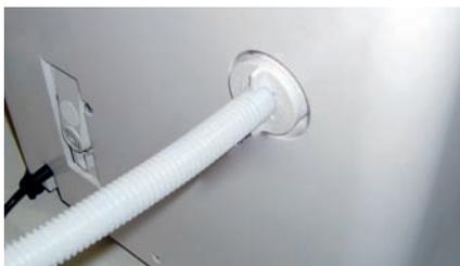
Das Kondensat ist im unbeaufsichtigten Dauerbetrieb vorzugsweise in einen tieferliegenden Abfluss abzuleiten.
