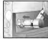
4: Anker mit dem Montage-drehmoment  $T_{inst}$  verspreizen
