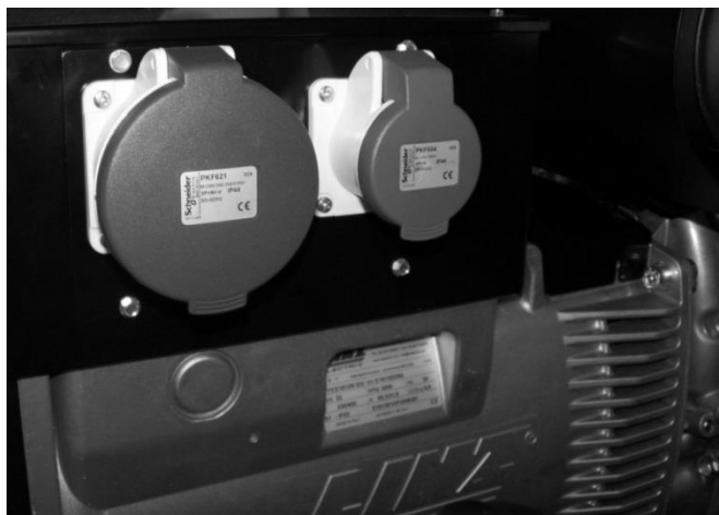
Abb. 3-2: Verbraucher anschließen
