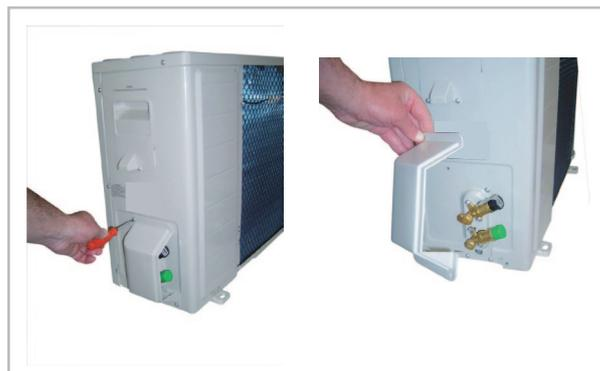
Abb. 19: Kunststoffblende entfernen
