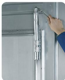
Den massiven Sechskantkopf mit Bohrspitze mit einem 27er Maulschlüssel fest unter dem Sturz arretieren,
