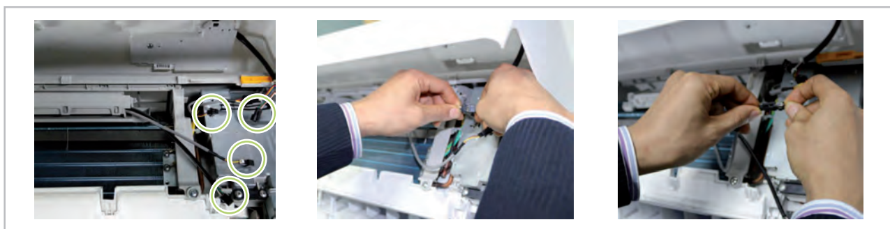
Abb. 7: Mit der Display- und Steuerplatine verbinden
